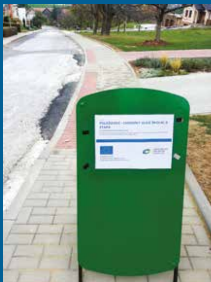
Dokončený chodník v ulici Školní
