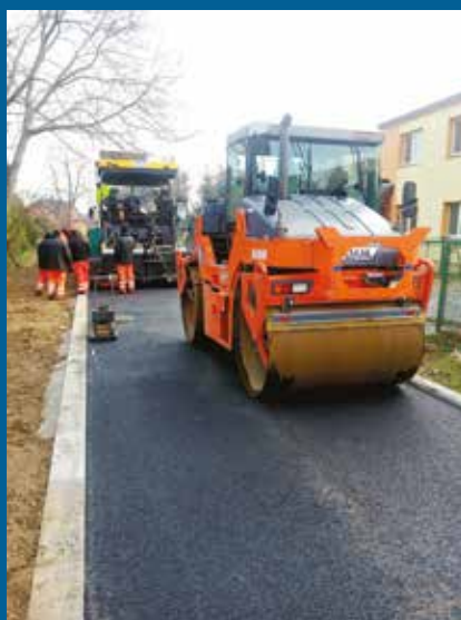
Dokončovací práce asfaltování Nové čtvrti
