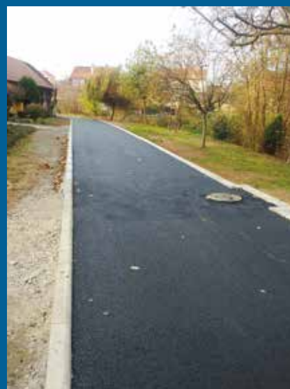
Nová silnice na Nové čtvrti
