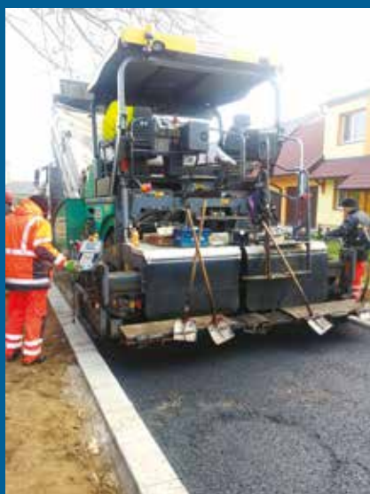
Asfaltování Nové čtvrti
