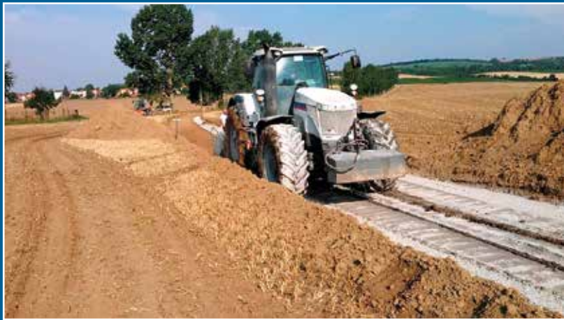
Výstavba cyklostezky Polešovice – Nedakonice
