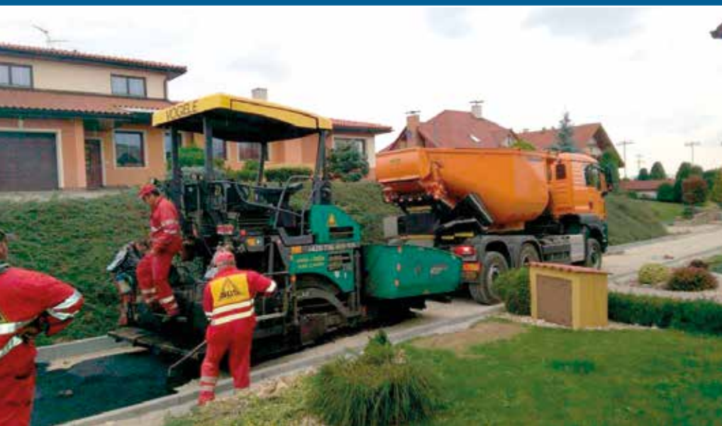
Výstavba komunikace na Suchém Řádku
