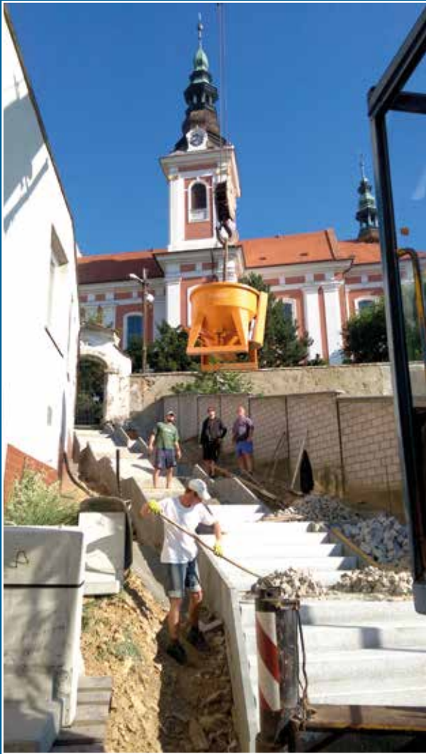
Práce na schodišti ke kostelu
