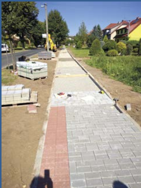
Rekonstrukce chodníku na Salajce
