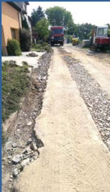
Oprava místní komunikace v Míškách
