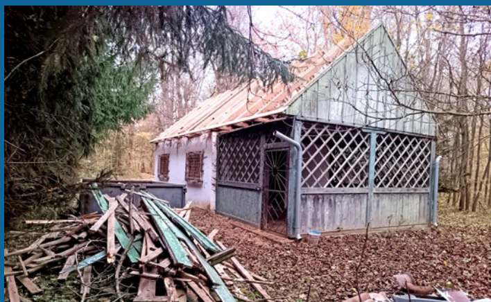
Výměna střechy na singulární boudce v Dolním lese
