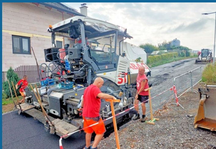
Práce na místní komunikaci na Dílech
