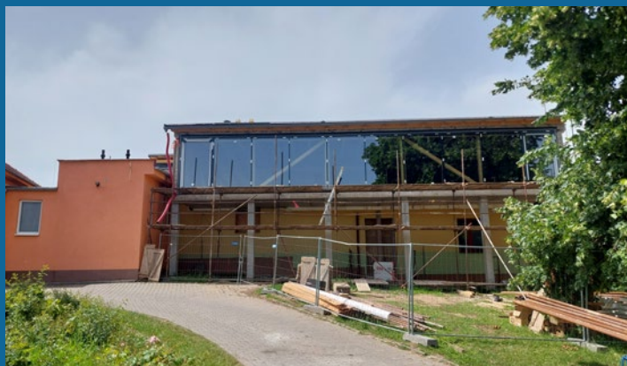
Přístavba školní družiny
