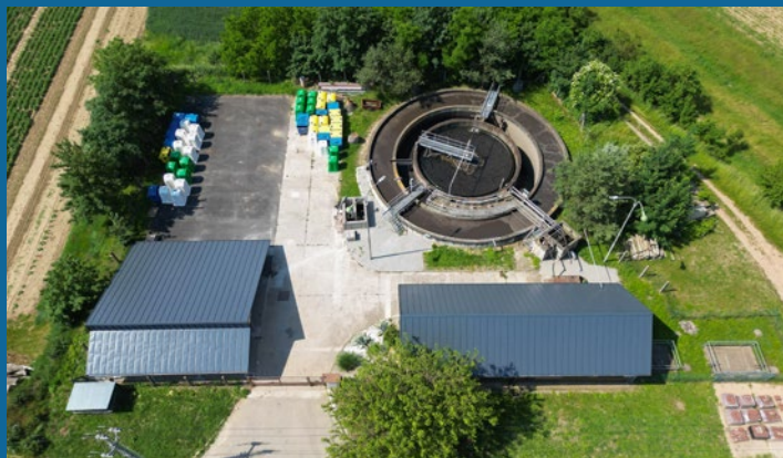
Pohled na čistírnu odpadních vod z výšky, na novou střechu budovy ČOV a nad kalolis budou umístěny panely FVE
