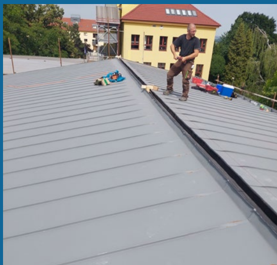
Práce na střeše školní družiny
