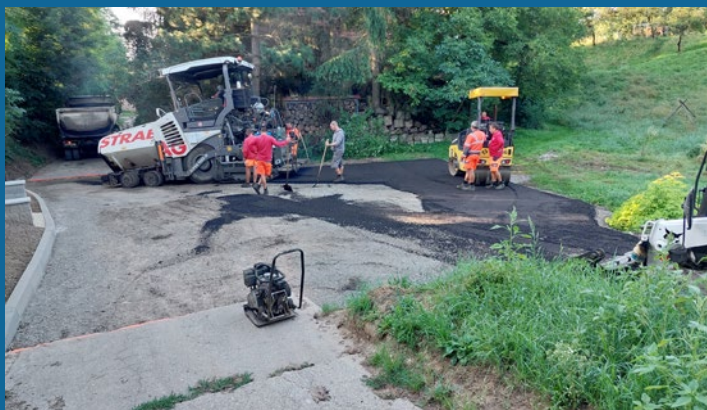
Oprava cesty pod vodojemem na Skale
