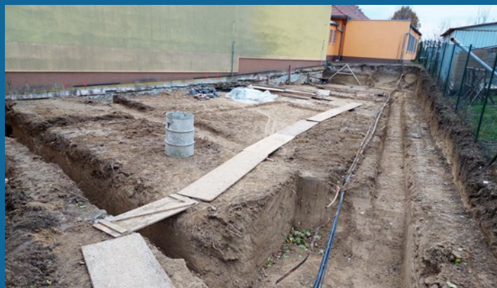
Práce na stavbě nových družin
