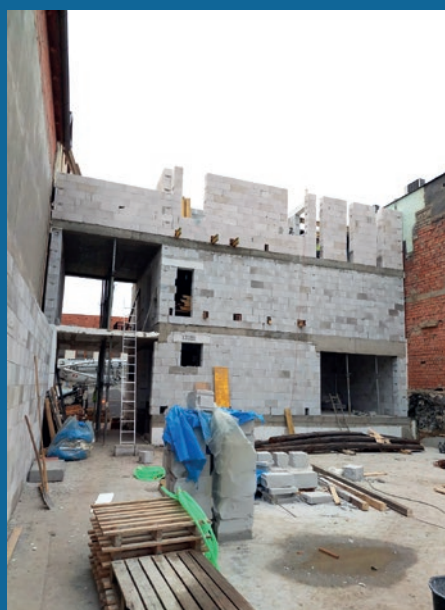
Stavba obecního penzionu ze zadní strany
