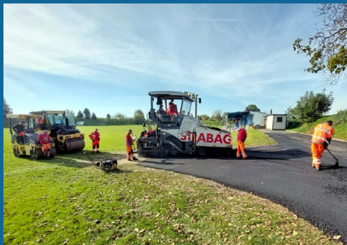
Práce na nové cestě na fotbalové hřiště
