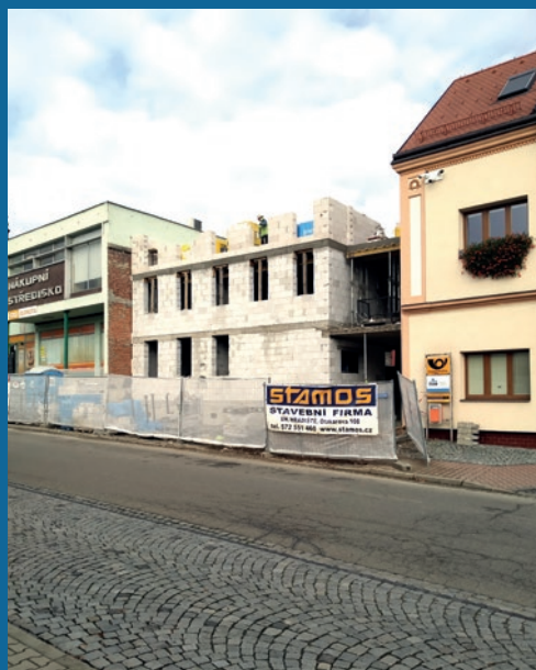
Pohled na stavbu penzionu z ulice
