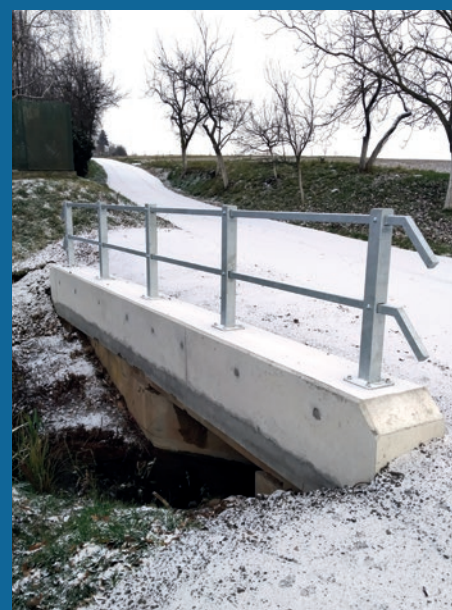
Opravený most u pily
